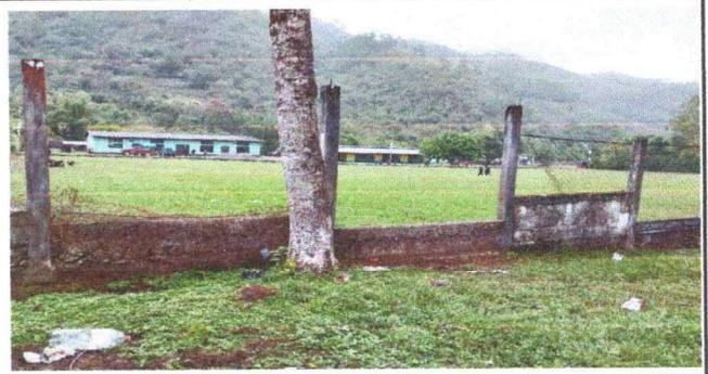
Foto 2: Sustitución de malla y parales, Se observa el deterioro de la malla
