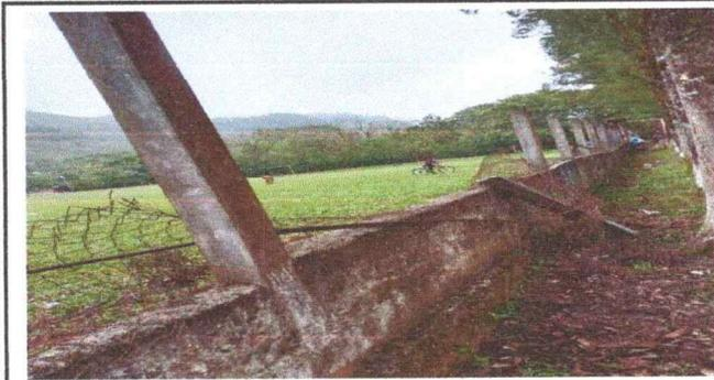
Foto 1: Reparación de muro perimetral de block. Ya que se observa el deterioro de la malla circular, y el deterioro de un paral de cemento.
