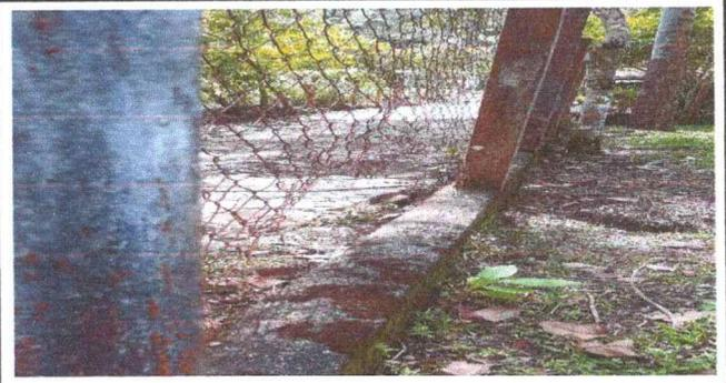
Foto 4: Reparación de cerco con malla galvanizada. Se observa el deterioro de la malla.
